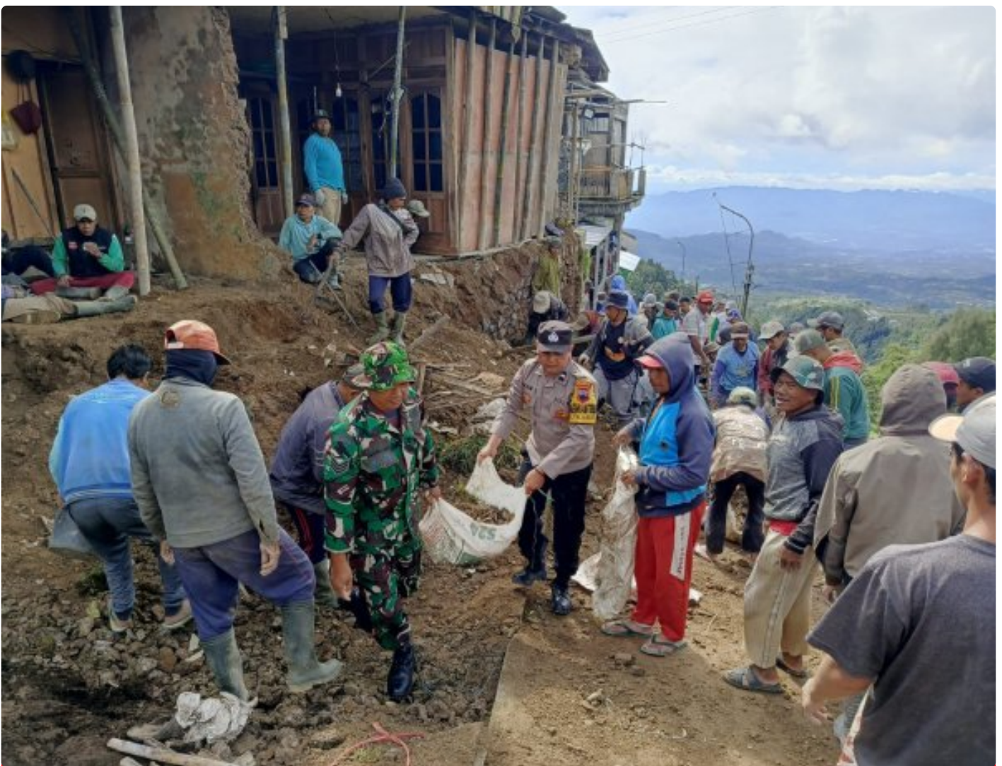
(Foto Dokumen) : Gotong royong pembersihan material longsor
